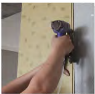
步骤5：用气枪钉固定，或者采用卡扣固定
