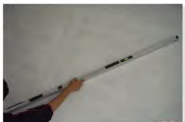
步骤1：墙面水平测量
